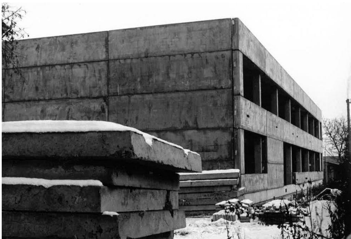
Stavba školní jídelny, rok 1990
